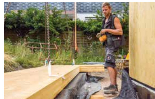
Dank der Vorfertigung braucht es für die Montage wenig Zeit.
