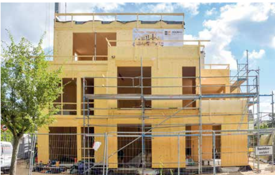
Das Zweifamilienhaus in Holzbauweise nimmt Gestalt an.
